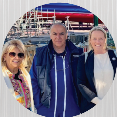
Visite privilégiée du chantier maritime Transmétal.
